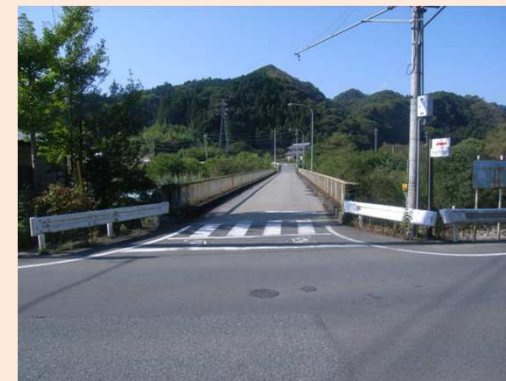
下小坂大橋（90.1m 31年経過）
