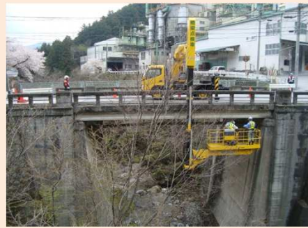
橋梁点検車による定期点検
