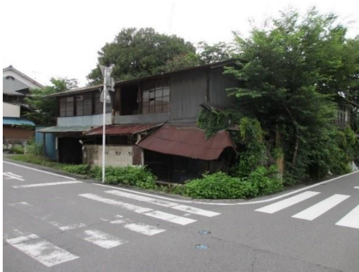
▲下仁田駅周辺の空き家
