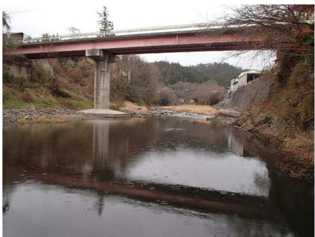
▲水質検査当日の八千代橋下 (撮影：平成 26 年 12 月 11 日)
