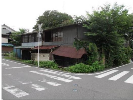
▲下仁田駅周辺の空き家
