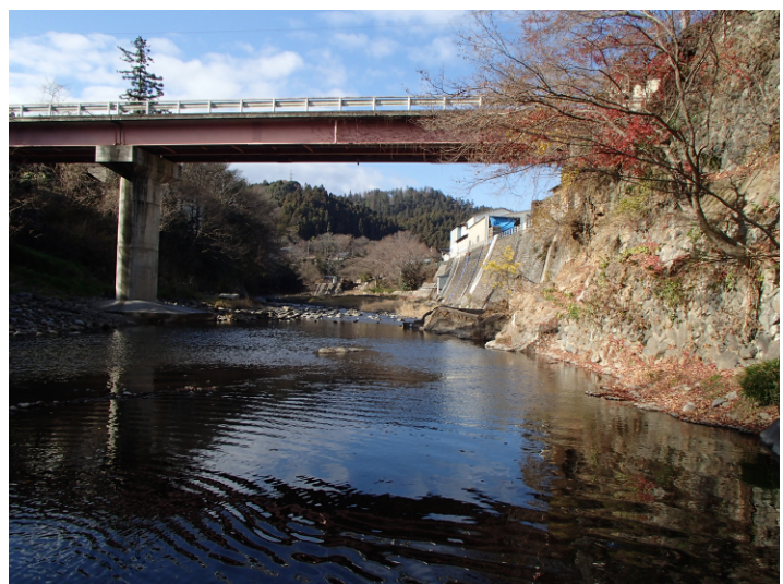
▲水質検査当日の八千代橋下(撮影:平成25年12月10日)
