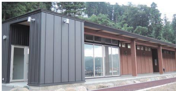
交流防災ステーション（道の駅東側）
