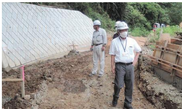
町道4333号目明石線 道路改良工事現場
