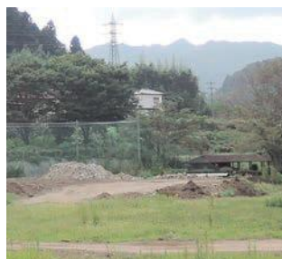
令和元年10月に台風19号被害を受けた下小坂グラウンドの現状
