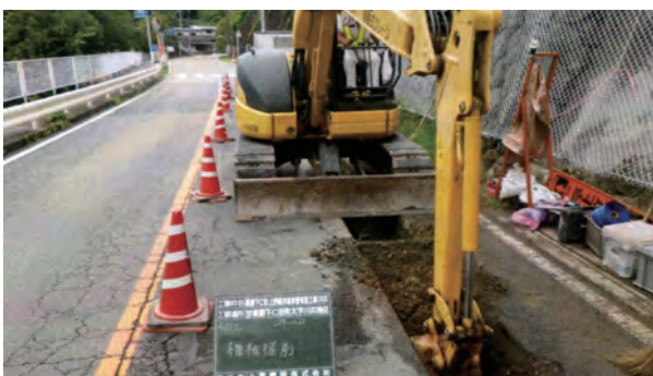
川井地内水道管布設替工事
