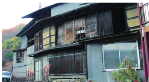
解体前の特定空家
