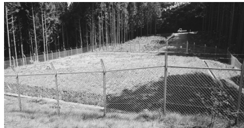
除染土壌仮置場
