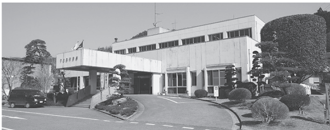
耐震が予定されている庁舎
