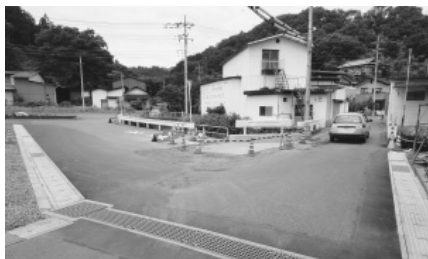
拡幅された森沢橋
