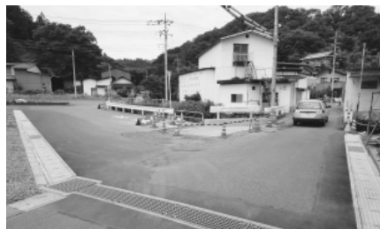
拡幅された森沢橋
