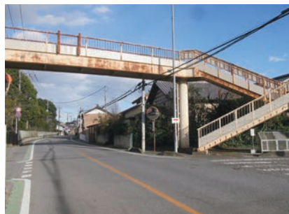
撤去された旧馬山小学校前歩道橋
