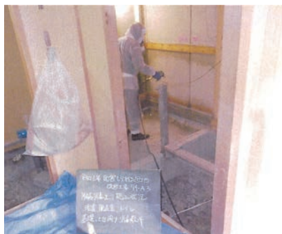
町営しらかば団地改修工事
