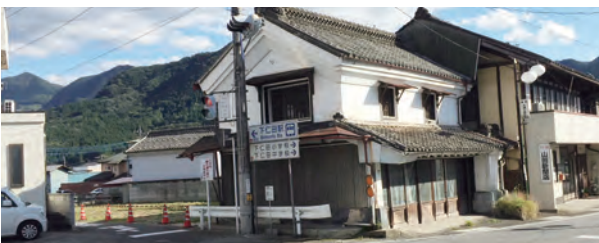
「チャレンジ交流拠点しもにた」建設予定地
