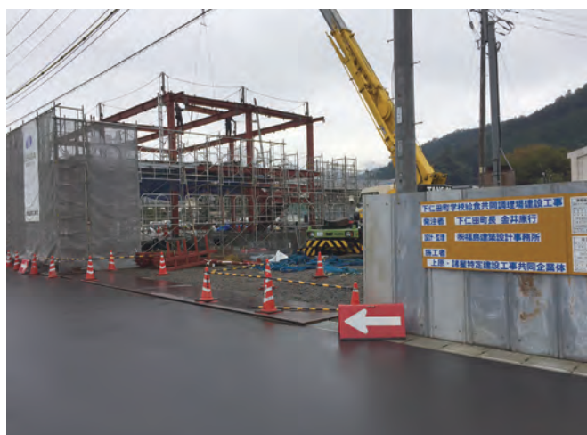
工事が進む下仁田町学校給食共同調理場 (平成 29 年 3 月末 完成予定)
