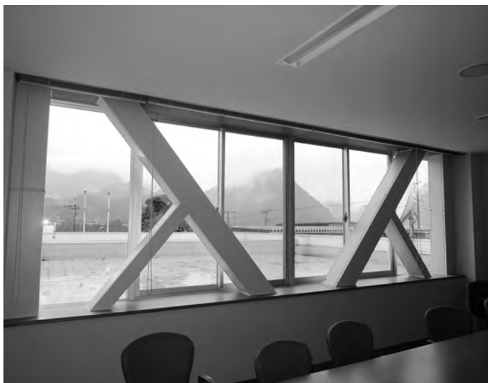
耐震補強工事 筋交い(すじかい)を新設
