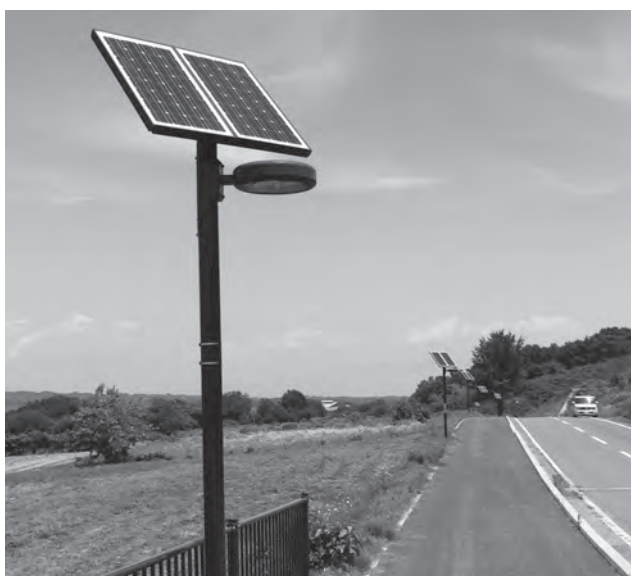
他町村で設置されているソーラー発電・LED照明
