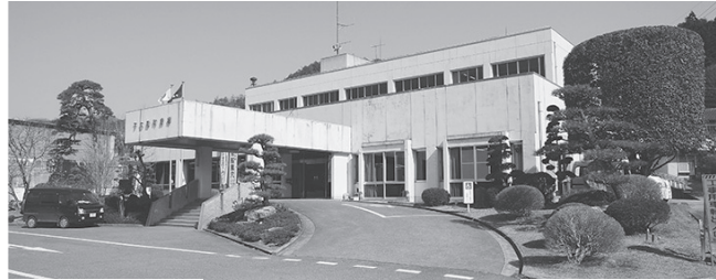
耐震が予定されている庁舎
