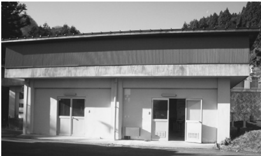
西部簡易水道
