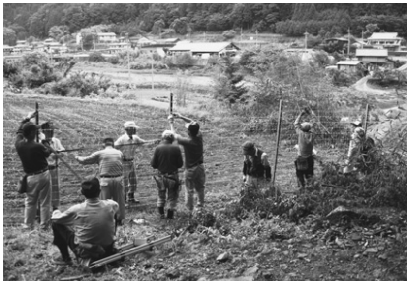
防護柵とり付の様子
