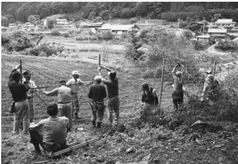
防護柵とり付の様子
