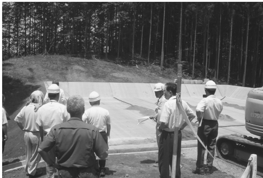
汚染土仮置場
