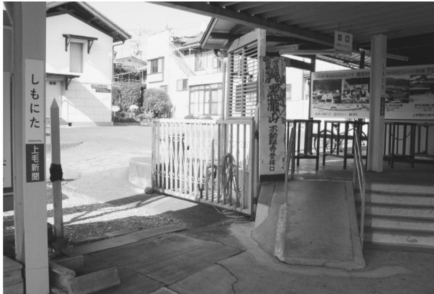
下仁田駅改札口 (改修予定)
