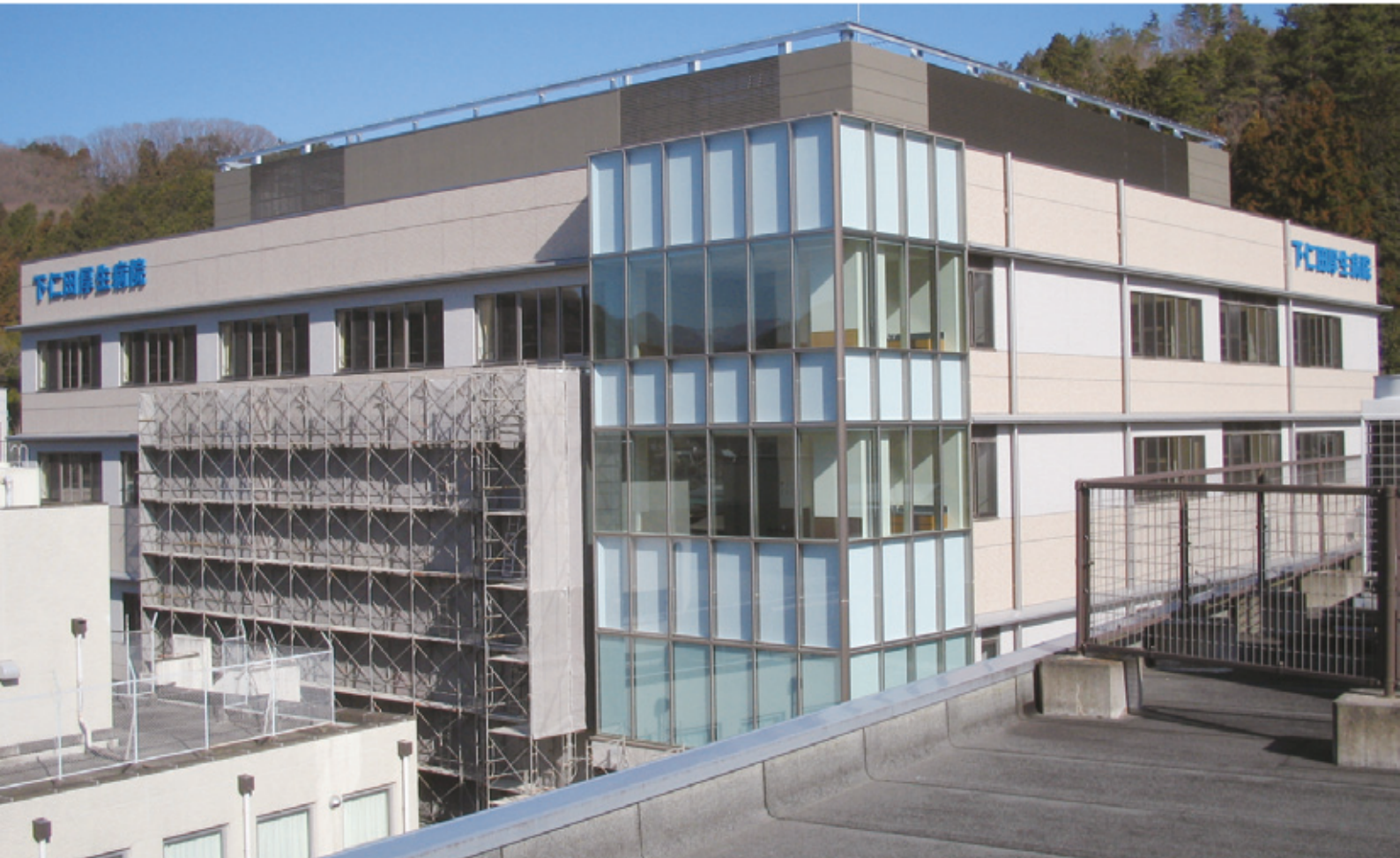
完成間近な下仁田厚生病院
