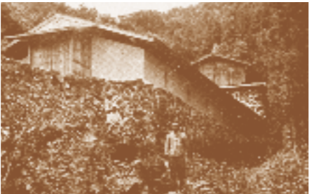
風穴建屋(2号風穴) 創業当時の建屋の様子を今に伝えます。現在の石積みの上に壁と屋根が設けられ、貯蔵を行っていました。
