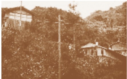
番舎(左)と1号(右奥)・ 2号風穴(中央右) 中央に写るのは電話線です。7km離れた運営母体「春秋館」との間に専用電話を敷設し、全国取引に対応しました。
