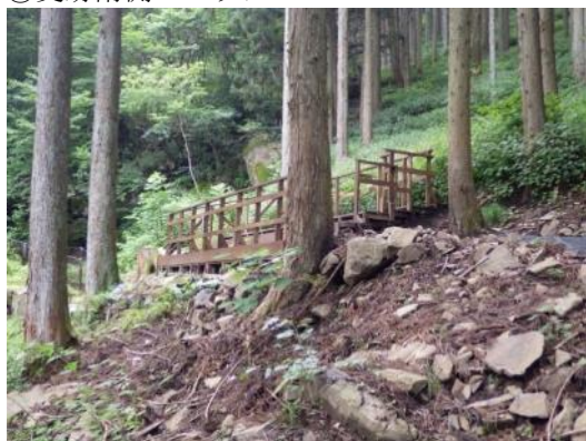
③石材置場（展望デッキ）
