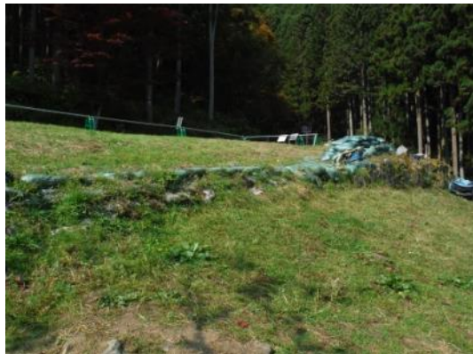
④土留め石積み
