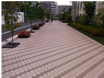
ブロック舗装
