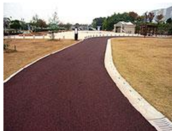
アスファルト舗装
