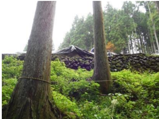
② 3号風穴東側の土留め石積み
