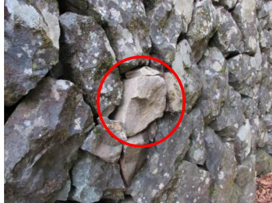
② 2号風穴南面上部（1石間詰め後）
