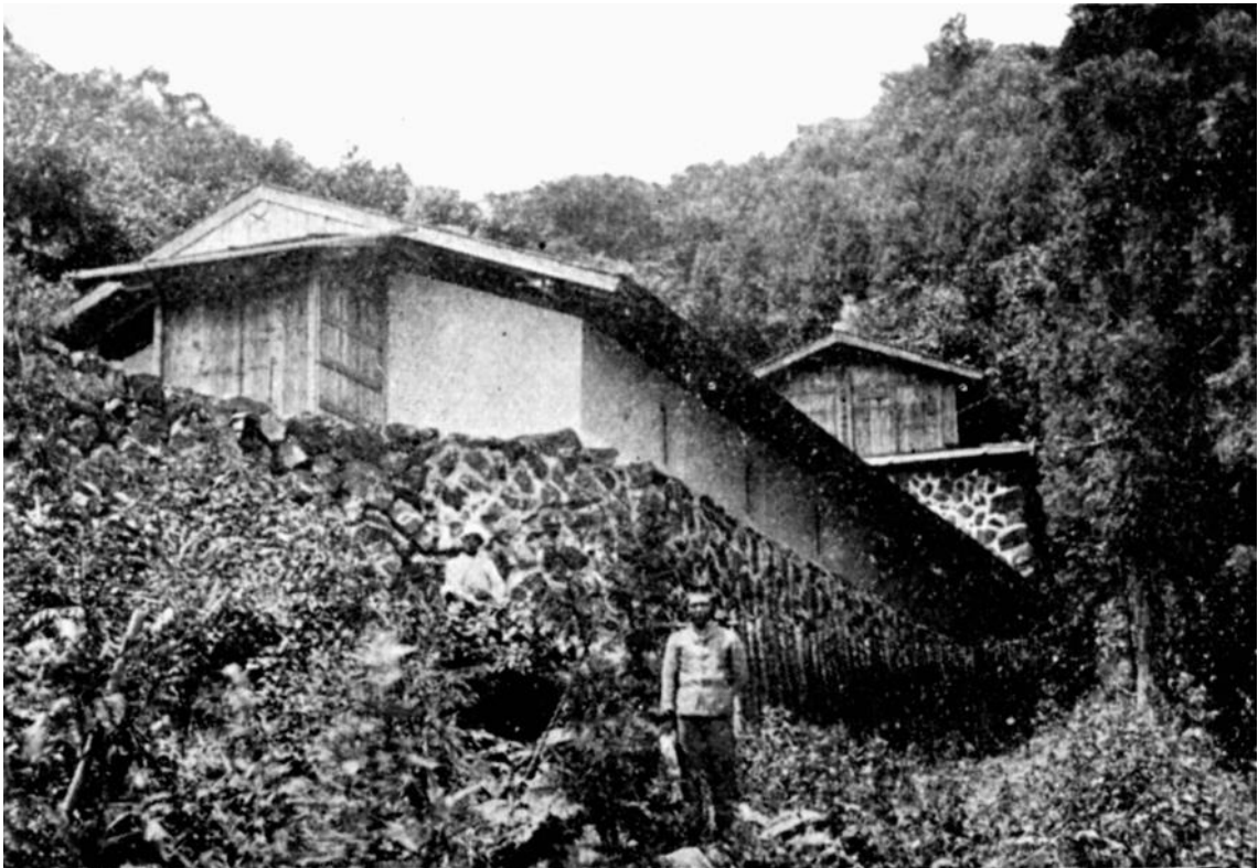
写真 2-3 明治 43 年頃の古写真 出典：『北甘楽郡案内』明治 43 年 9 月発行 (上：荒船風穴全景、下：全所側面)
