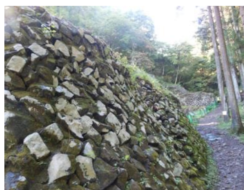
④ 3号風穴の補強 (はばき) 石積み
