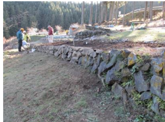
⑪ 土留め石積み (現在も地上に表出)
