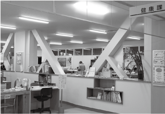
▲役場庁舎耐震工事
