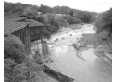
▲水車動力用のえん堤
