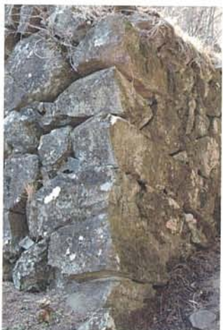
① 東角の石積みの状況
