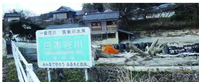
白木谷川流域の災害現場
